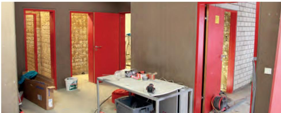
Die Abrissarbeiten sind abgeschlossen. Derzeit sind die Innenausbauer damit beschäftigt, die neuen Zwischenwände einzuziehen.
